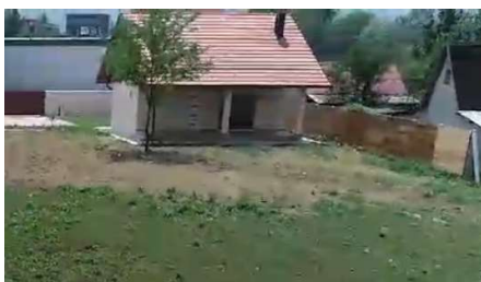
Slika.2: Postojeći stambeni objekat 1
